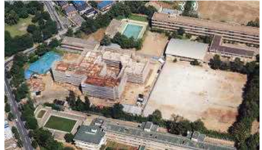
建築中の新校舎と旧校舎
