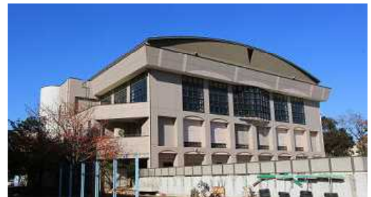
体育館（プール側より）
